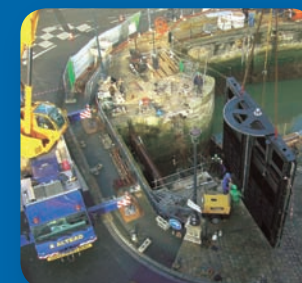
► Travaux sur ouvrages hydrauliques
