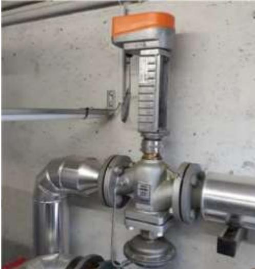
Exemple d'une vanne 2 voies à pression différentielle primaire sur le primaire des sous-stations
