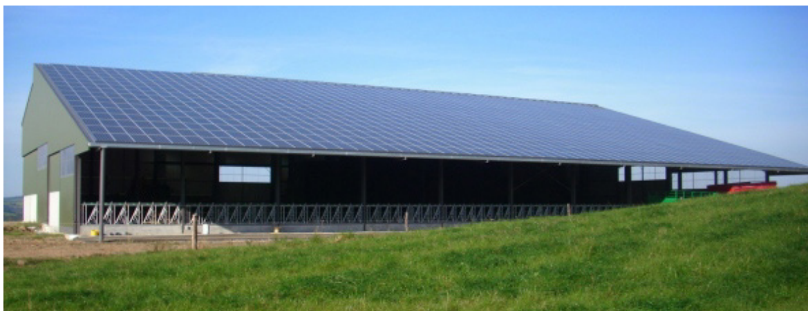
Exemples de dispositifs photovoltaïques installés sur la toiture d'une maison individuelle (intégration dans la toiture en ardoise) et d'un hangar agricole.
