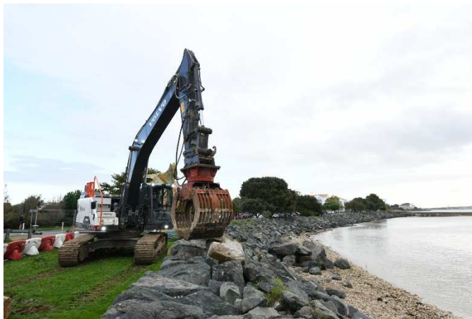
Travaux PAPI de Port Neuf à la Rochelle Photo Pierre Meunié – CdA de La Rochelle
