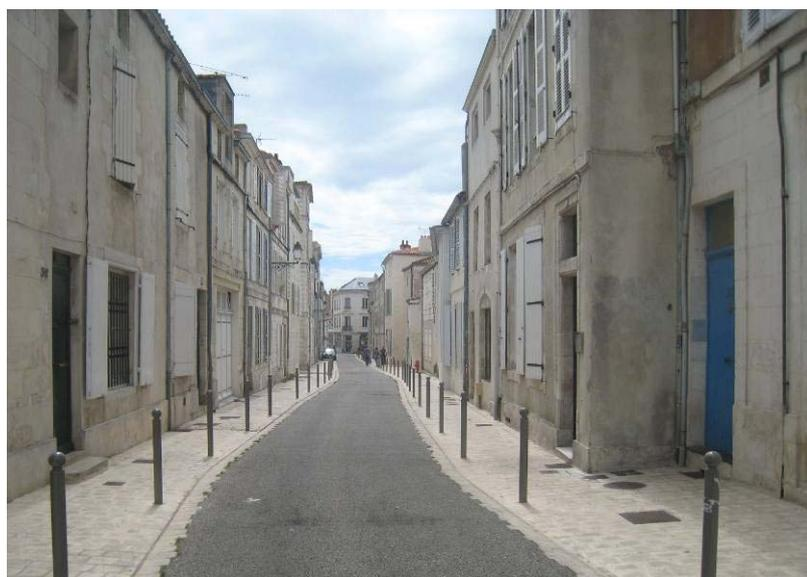
**Typologie courante :** la chaussée asphaltée est délimitée par deux fils d'eau en pavés de pierre calcaire.
