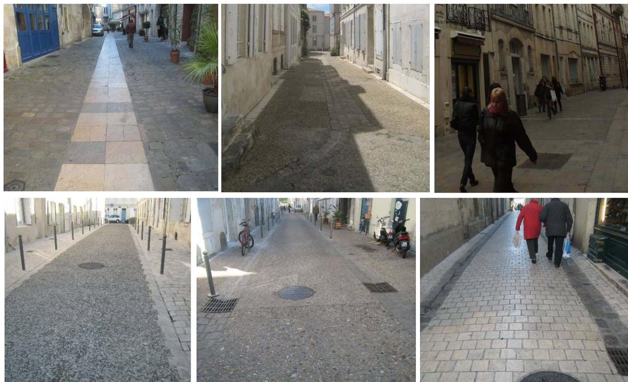
*Trottoir en pavés de granit avec bordures et caniveaux en béton.*
