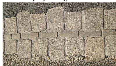
Le modèle est décliné avec différents matériaux : chaussée et trottoirs en béton désactivé ou pavés – fil d'eau de matériau différent en contraste.
