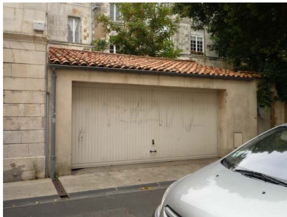
4bis rue de l'Escale Garage construit sur la rue.
