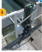
L'eau subit alors une nouvelle chloration avant d'être acheminée vers quatre filtres à sable. Elle percole à travers une épaisseur d'environ un mètre de sable, puis au travers des 2 500 petites buses qui composent le fond de chaque filtre. Dès qu'un filtre est colmaté, il est nettoyé à contre courant avec de l'air et de l'eau.
