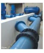
Deux systèmes "anti-bélier" permettent d'amortir l'onde de choc dans la canalisation à l'arrêt des pompes.
