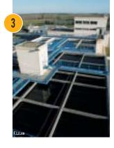
A cette étape, l'eau arrive dans un décanteur. Elle y reçoit un traitement à base de charbon actif en poudre (CAP) contre les pesticides, et éventuellement un traitement aux polymères si elle est extrêmement trouble. Sous l'effet du coagulant, les matières en suspension agglomérées se déposent et forment un lit de boues qui sont évacuées. L'eau est récupérée en surface.
